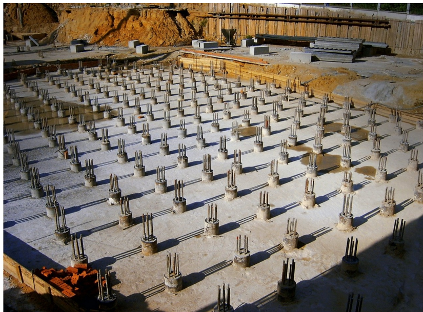
Рисунок 7. Свайное поле перед устройством надземных конструкций.
