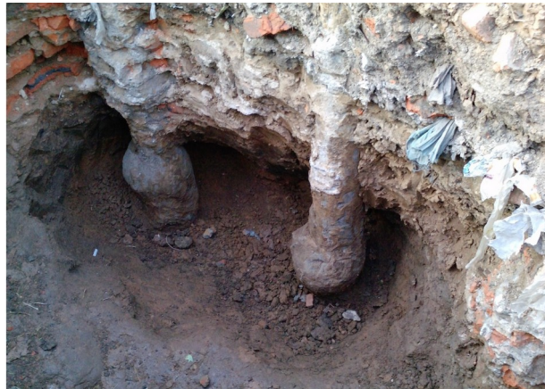
Рисунок 4. Вскрытые участки свай с локальными уширениями, два ракурса.
