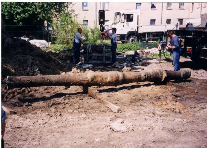
Рисунок 6. Извлечённая свая с уширениями по длине ствола.
